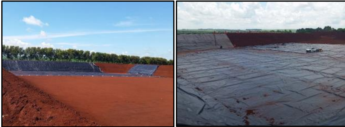
Figura 16 – Exemplo de impermeabilização da célula com manta PEAD.
