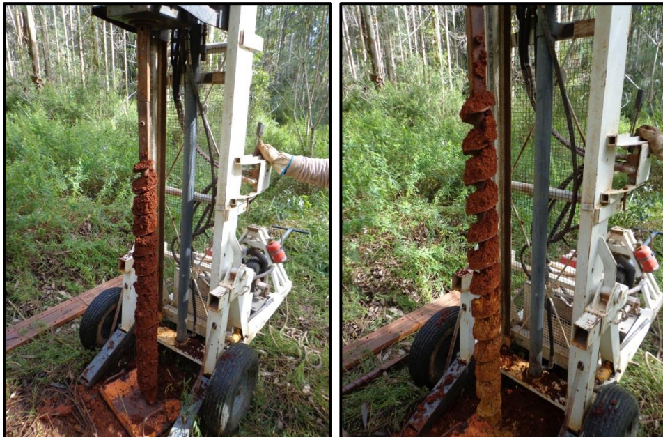
Figura 69 – Perfuração da sondagem ST-01.
