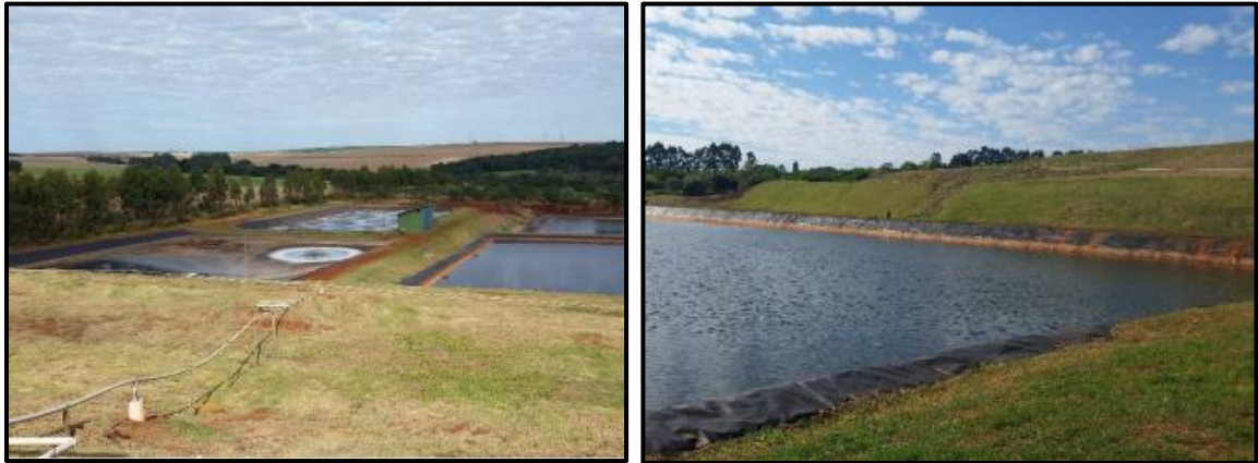
Figura 34 – Exemplo de lagoas de tratamento do chorume.
