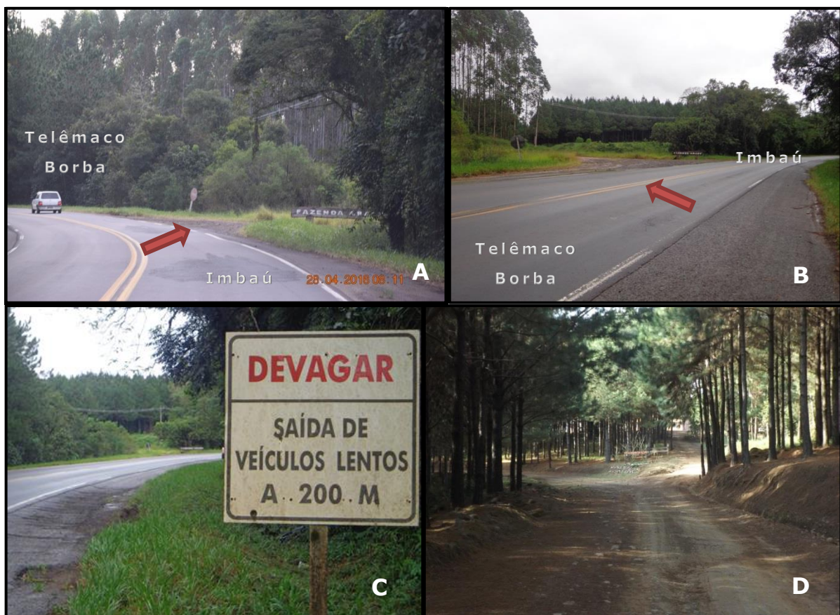
Figura 137 – Intersecção entre a PR-160 (A e B), sinalização (C) e via secundária de acesso (D).
