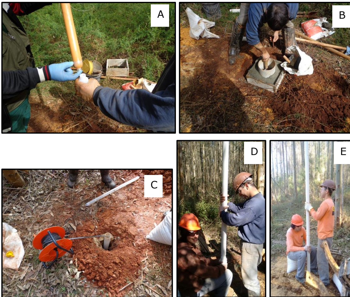
Figura 77 – A - Coleta de água subterrânea; B - finalização do poço; C - medição do nível d'água; D e E – instalação e descida do tubo de revestimento no poço.
