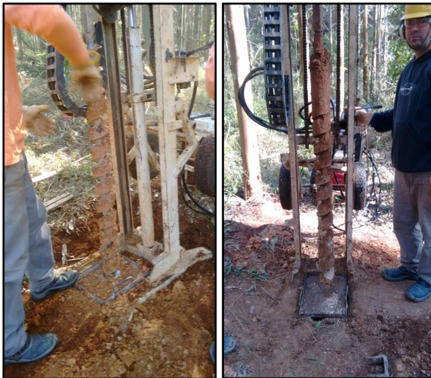
Figura 75 – Execução da sondagem ST-04.
