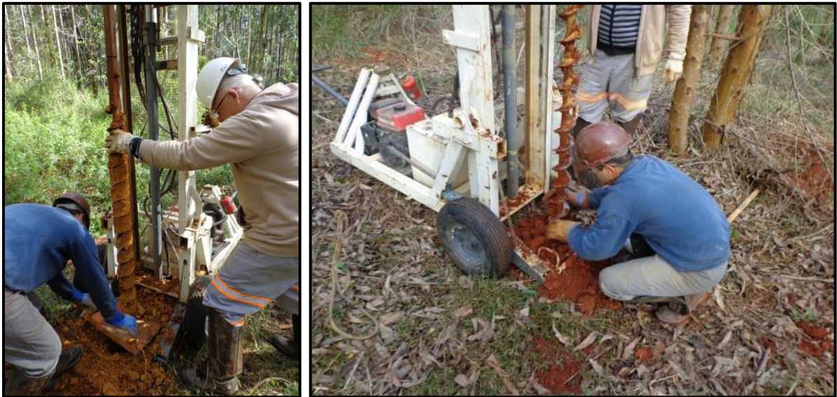
Figura 73 – Execução da sondagem ST-03.
