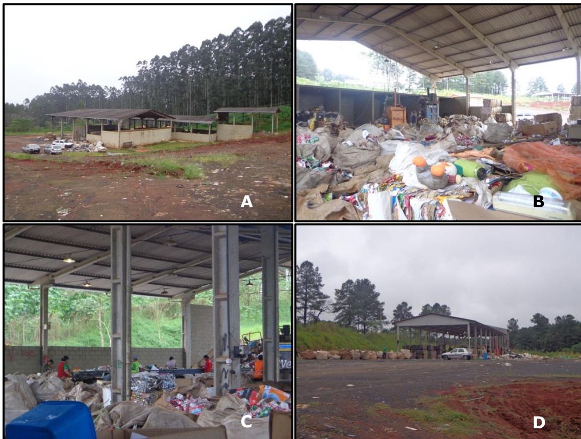
Figura 158 – Galpões de triagem (A), material separado e prensas (B), esteira automática de triagem (C) e galpão armazenamento de material prensado (D)
