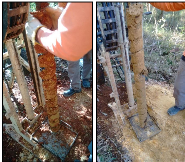
Figura 71 – Execução da sondagem ST-02.
