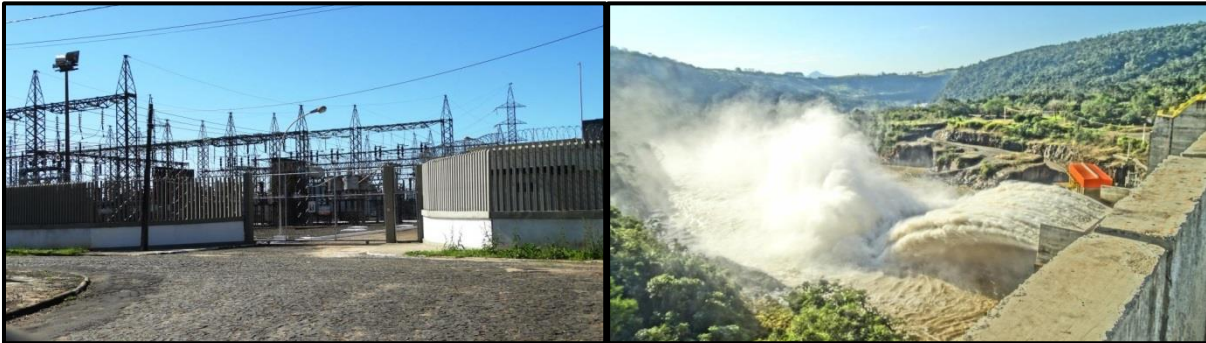
Figura 138 – Subestação de energia elétrica da COPEL em Telêmaco Borba e barramento/vertedouro da UHE Mauá na divisa entre Telêmaco Borba e Ortigueira.
